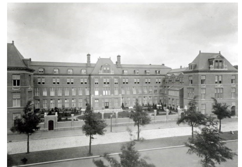
Kraamkliniek aan de Henegouwerlaan 72 te Rotterdam.
